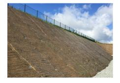
"La solution Terra-Lock de Gripple nous a permis de stabiliser le talus entier contrairement à un enrochement. De plus, sa mise en place est facile, rapide, et nous a permis d'éviter l'utilisation d'engins de terrassement."
